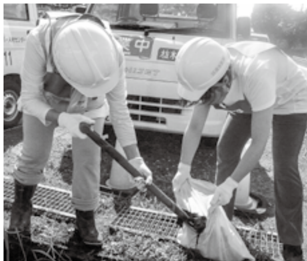
▲総合福祉センター内の側溝にたまった土砂をかき出す訓練。
